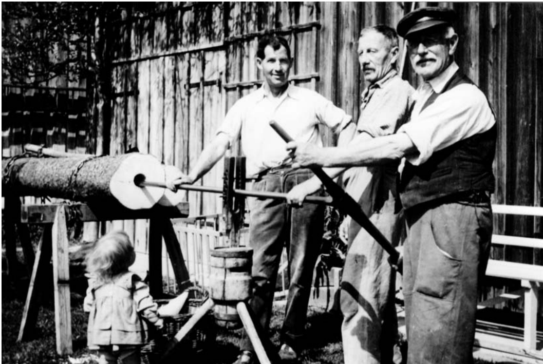
Letzte Arbeit bei Jsidor Niederer: Teuchel bohren in Gaissau. Von rechts nach links: Jsidor Niederer, Eugen Blum (Vater von Julius Blum, Beschläge, Höchst), Franz Metzler (Gaissau) und Astrid Winkler (Grosskind von Jsidor Niederer).
