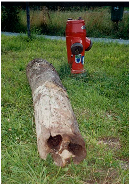
Verteiler aus Holz mit Hydrant
